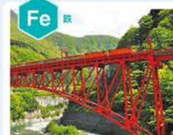
図A 橋梁 鉄は、硬くて強く加工もしやすい。橋・ビル・機械の部品をはじめ、幅広く利用されている。
