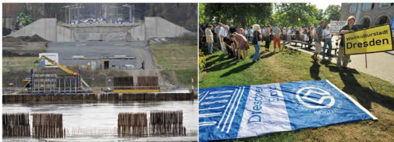
新しい橋の建設工事
