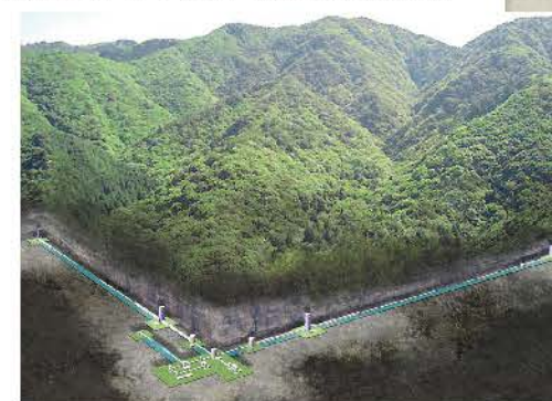
図2 重力波望遠鏡KAGRAのイメージ図。岐阜県と富山県の県境の地下にある。L字型に伸びる腕は長さそれぞれ3kmで、ここを通るレーザー光線どうしが干渉縞をつくり、重力波が到来すると、そのようすがわずかに変化する。
