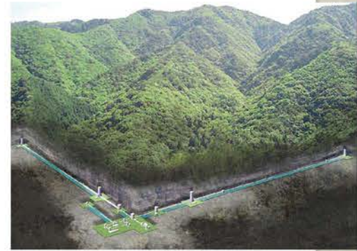
図2 重力波望遠鏡KAGRAのイメージ。岐阜県と富山県の県境の地下にある。L字型に伸びる腕は長さそれぞれ3kmで、ここを通るレーザー光線どうしが干渉縞をつくり、重力波が到来すると、そのようすがわずかに変化する。
